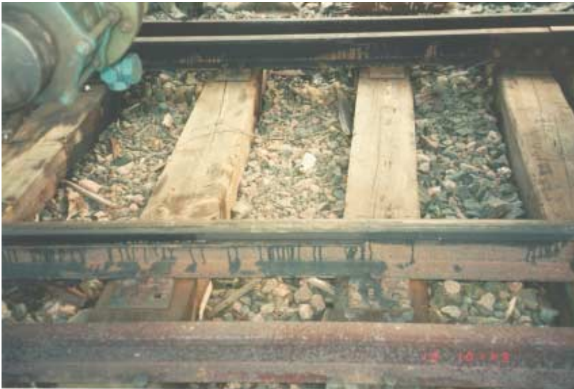
Kuva 5. Raidepuskimen kiinnityskohta oli noin 8 metrin päässä kiskojen päästä.
