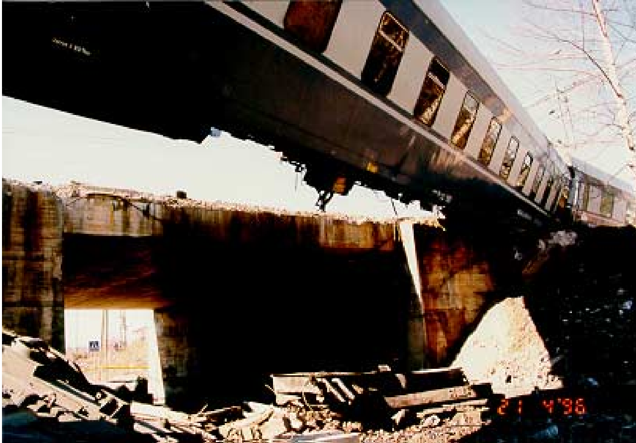
Kuva 7. Onnettomuusjunassa kuudentena ollut makuuvaunu jäi roikkumaan alikulkusillan kohdalle tyhjän päälle. Vaunusta irronneet telit putosivat alla olevalle tielle.
