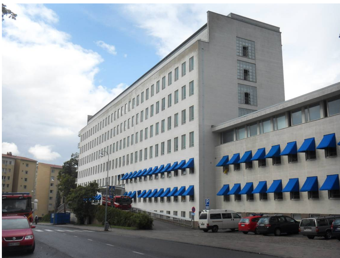
Kuva 1. A-sairaala idästä kuvattuna. Ensiapupoliklinikan ramppi näkyy etualalla keskellä. Oikealla on matalampi rakennuksen laajennusosa (B-siipi).
