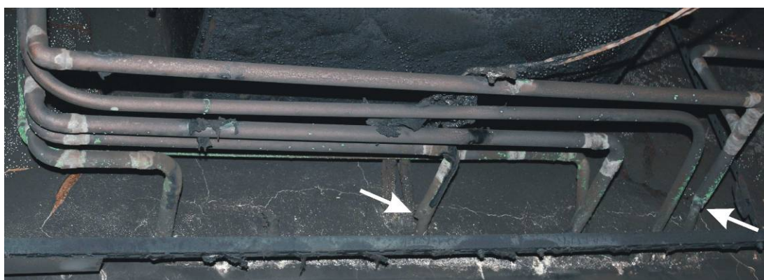
Kuva 16. Esimerkiksi kolmannessa kerroksessa osassa liitoksissa oli huomattavan erikokoisia putkia liitetty yhteen puristamalla suuremman putken reunaa kasaan (valkoiset nuolet).
