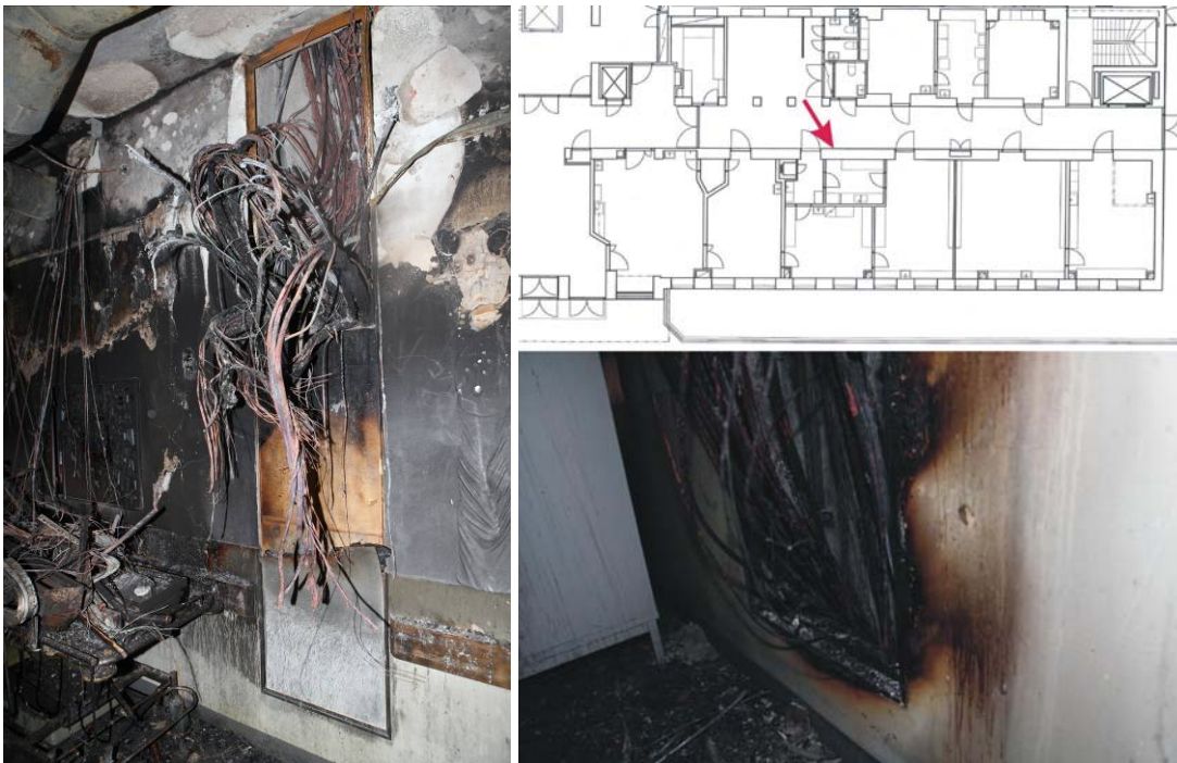
Kuva22. Vasen kuva toisesta kerroksesta ja oikea alakuva kolmannesta. Palo levisi kerroksesta toiseen kaapeliroiloa pitkin. Kaapeliroilon paikka on merkitty punaisella nuolella 2. kerroksen pohjapiirrokseseen. (Valokuvat poliisi)
