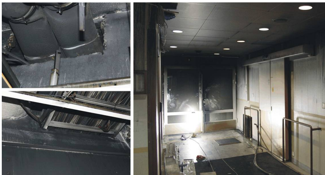
Kuva 13. Oikealla kuva 2. kerroksen aulasta kohti palaneen ensiapupoliklinikan ovia. Vasemmalla ovien kohdalla alaslasketun katon yläpuolella olleita läpivientejä. Savu levisi nopeasti läpivientiaukoista.
