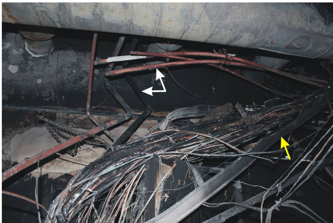
Kuva 21. Kupariset kaasuputket (valkoiset nuolet) olivat kaapelikourun yläpuolella. Kuvassa alumiininen kaapelikouru (keltainen nuoli) on osittain pudonnut tulipalon aiheuttaman kuumuuden takia.
