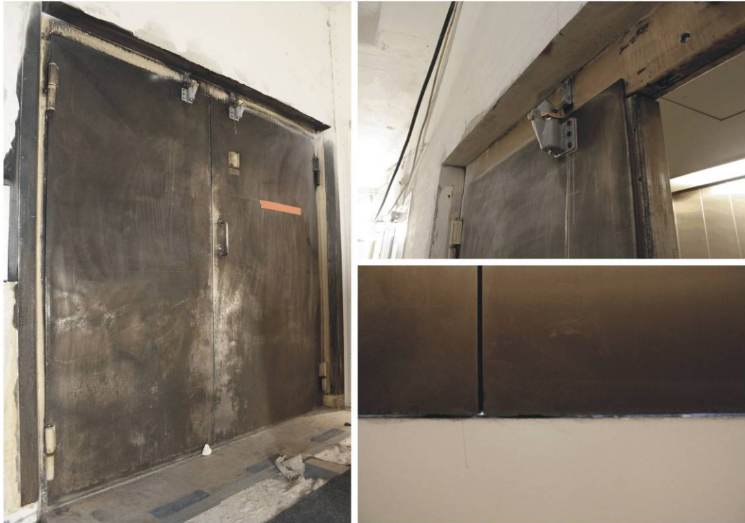
Kuva 19. Paloalueella ollut hissi. Vasemmalla paloalueelle jääneen hissien ovet 2. kerroksessa. Kuva on otettu palon jälkeisen korjaustyön ollessa käynnissä. Oikealla alhaalla ovien alareunan välinen rako hissikuilusta päin kuvattuna.
