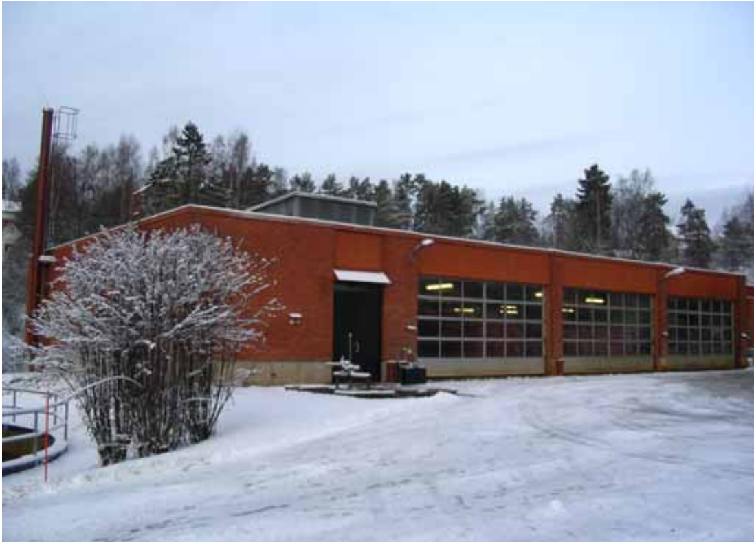
Kuva 2. Kullaanvuoren jätevedenpuhdistamo. Bild 2. Avloppsreningsverket i Kullaanvuori Figure 2. The wastewater treatment plant of Kullaanvuori
