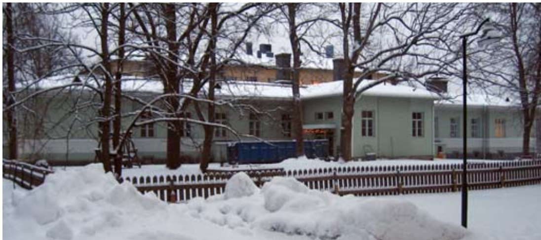
Kuva 3. Rakennus 17 pääoven suunnasta kuvattuna. Pääoven edessä oleva roskalava on tuotu paikalle onnettomuuden jälkeen.
