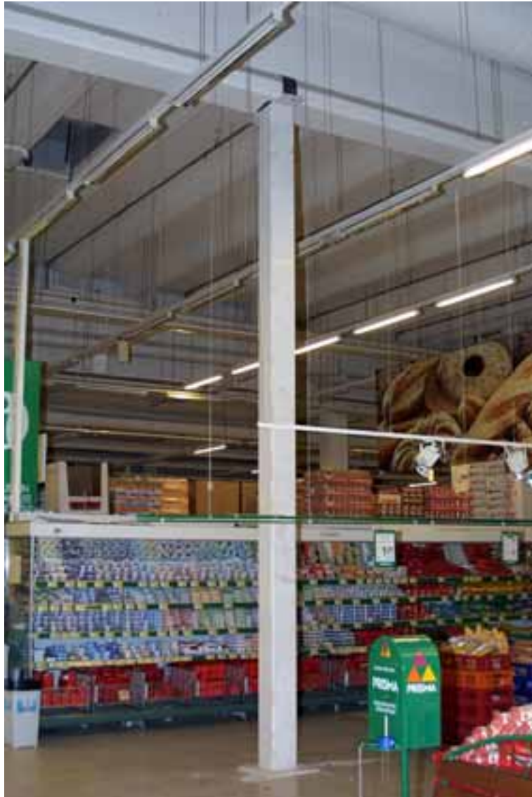
Kuva 3. Kuva kattopalkin väliaikaisesta tuennasta.
