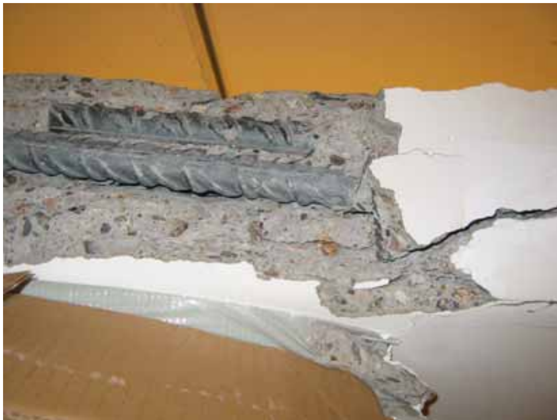
Kuva 11. Palkin raudoitus edestä katsottuna harjan oikealla puolella.
