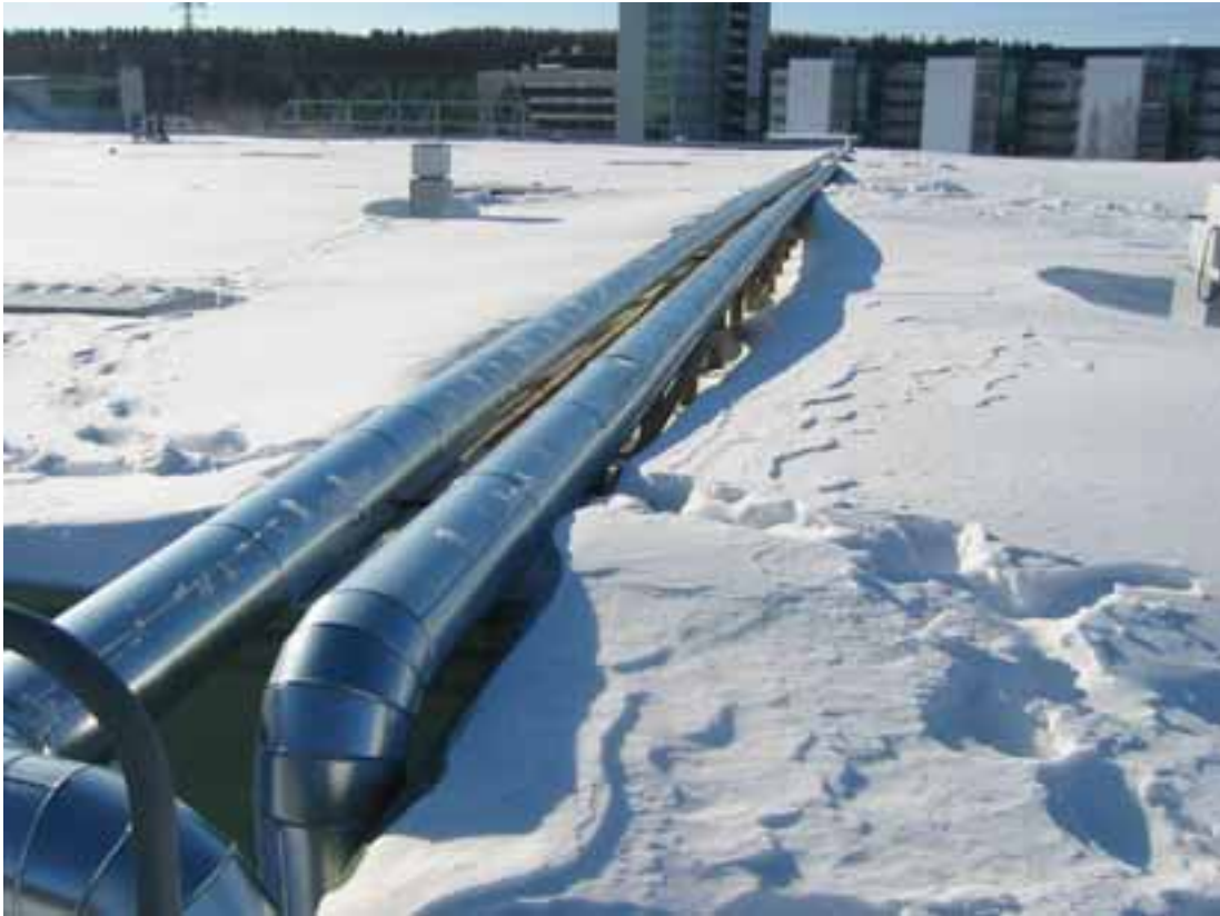
Kuva 8. Kauppakeskuksen katolle rakennettu glykoliputkisto.
