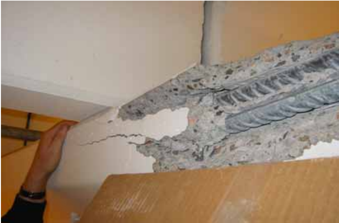
Kuva 9. Palkin raudoitus edestä katsottuna harjan vasemmalla puolella.
