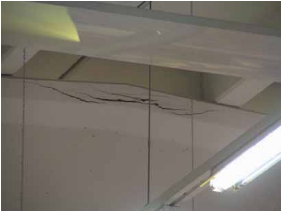
Kuva 2. Kuva palkin harjalla olevista halkeamista.
