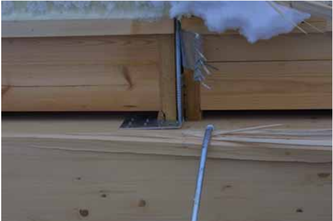
Kuva 15. Ristikön 31 yläpaarteen päälle tulevat kattoelementit olivat hiukan eri levyisiä, joten niiden kiinnitys tuotti ongelmia. Kuvaussuunnan puoleinen kattoelementti on pudonnut kattovaurion yhteydessä pois ristikön päältä. (Kuva: Poliisin arkisto)
