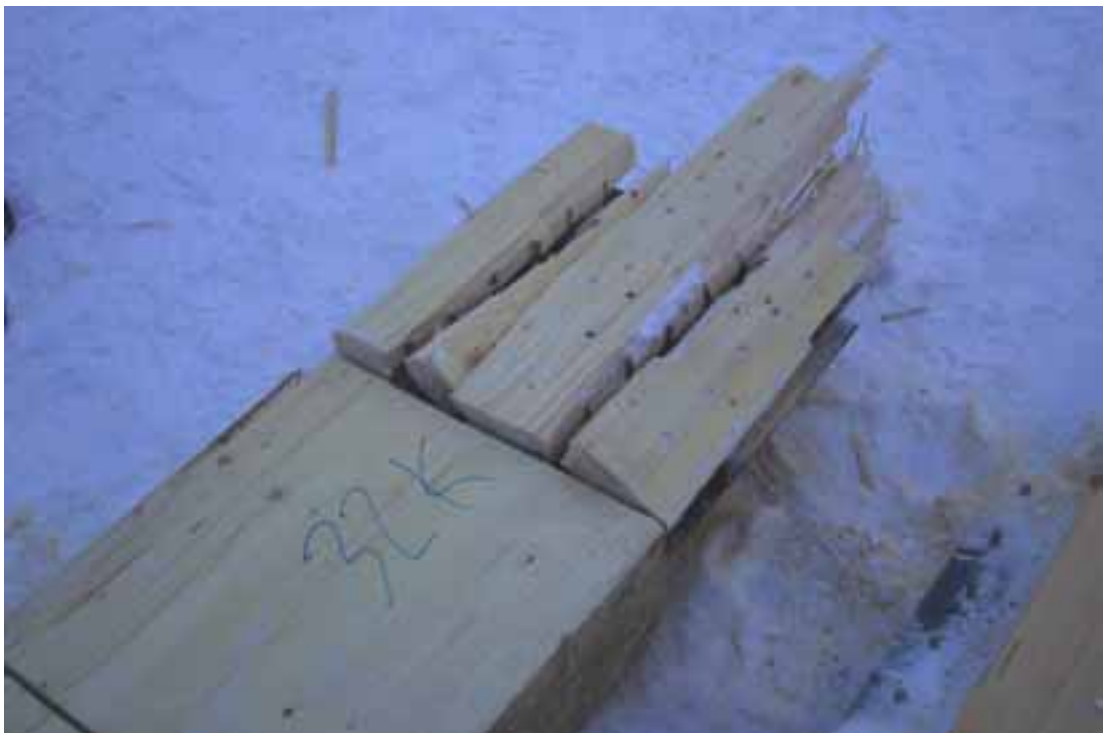
Kuva 20. Ristikkoparin 32 alapaarteen jatkokset, jotka oli tehty työmaalla. Liitokset eivät olleet pettäneet onnettomuudessa. Alemmassa kuvassa puu on rikkoutunut ristikon lattialle putoamisen seurauksena. (Kuva: Poliisin arkisto)
