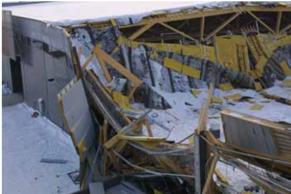
Kuva 14. Kuvan alareunassa ristikkoparin 34 tukipilari kaatuneena. Kuvan etualalla näkyy ristikkoparin 33 ulkoseinän puoleinen pilari. Taka-alalla on ristikkoparin 35 pilarissa edelleen kiinni oleva osa sekä ylös jäänyt ristikkopari 36. (Kuva: Poliisin arkisto)
