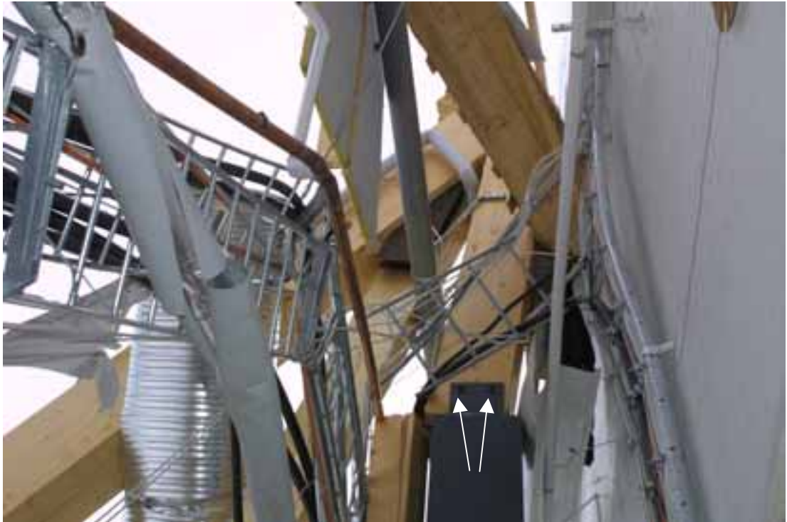
Kuva 7. Teräsbetonipilareiden yläpäähän oli ankkuroitu teräslevystä valmistetut kiinnityskorvakkeet, joihin ristikkoparit oli kiinnitetty kahdella noin 500 mm pitkällä Ø 20 mm pultilla. Kuvassa ristikkoparin 32 se pää, jonka on todettu pettäneen ensimmäisenä. (Kuva: Poliisin arkisto)
