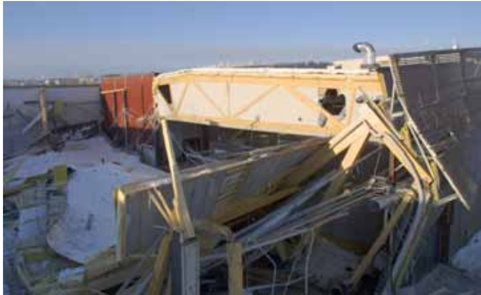
Kuva 13. Etualalla ristikkoparin 33 tukena ollut teräsbetonipilari. Seuraavana oikealla on sortunut ristikkolinja 32, jonka ristikkoparin päät ovat edelleen osittain pilarin päällä. Kuvassa edelleen ylhäällä oleva lyhyempi ristikko on ristikko 31. (Kuva: Poliisin arkisto)
