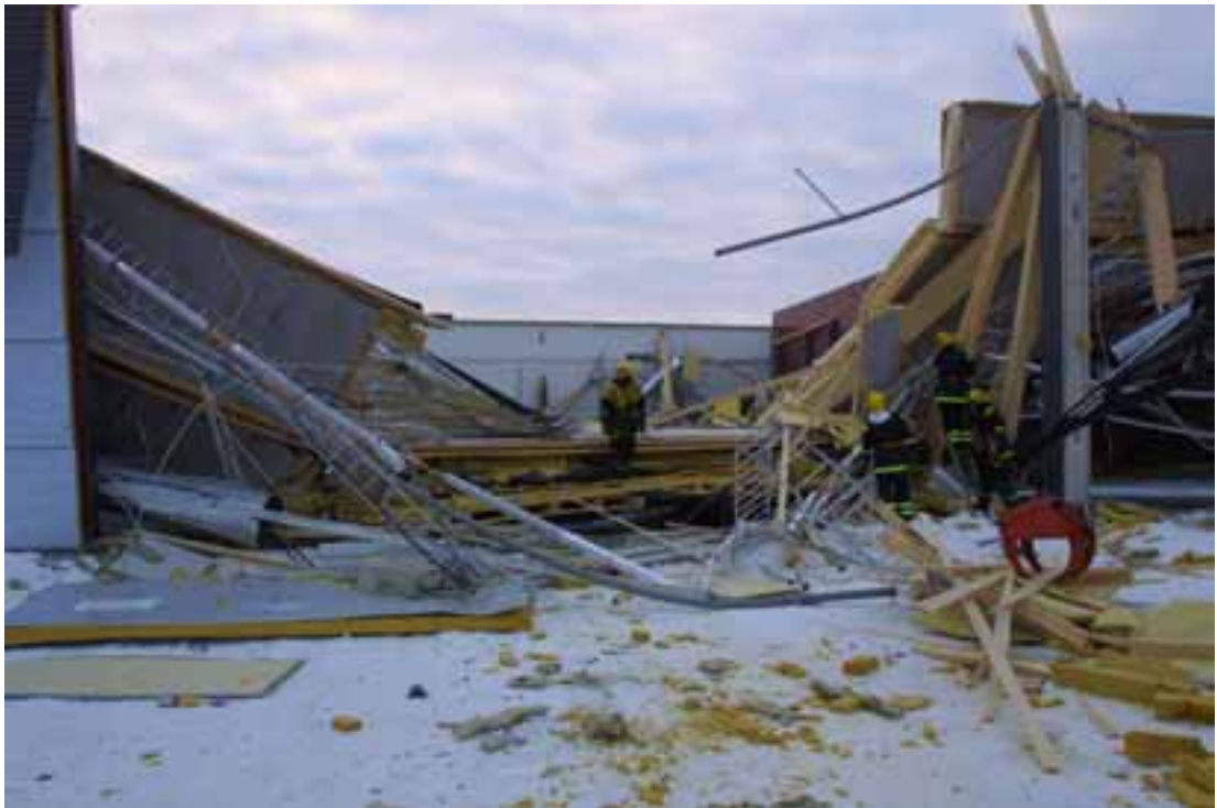
Kuva 4. Kuva vaurioalueelta raivaustyön alkuvaiheesta. Kuva on otettu b3-oven ulkopuolella. (Kuva: Poliisin arkisto)
