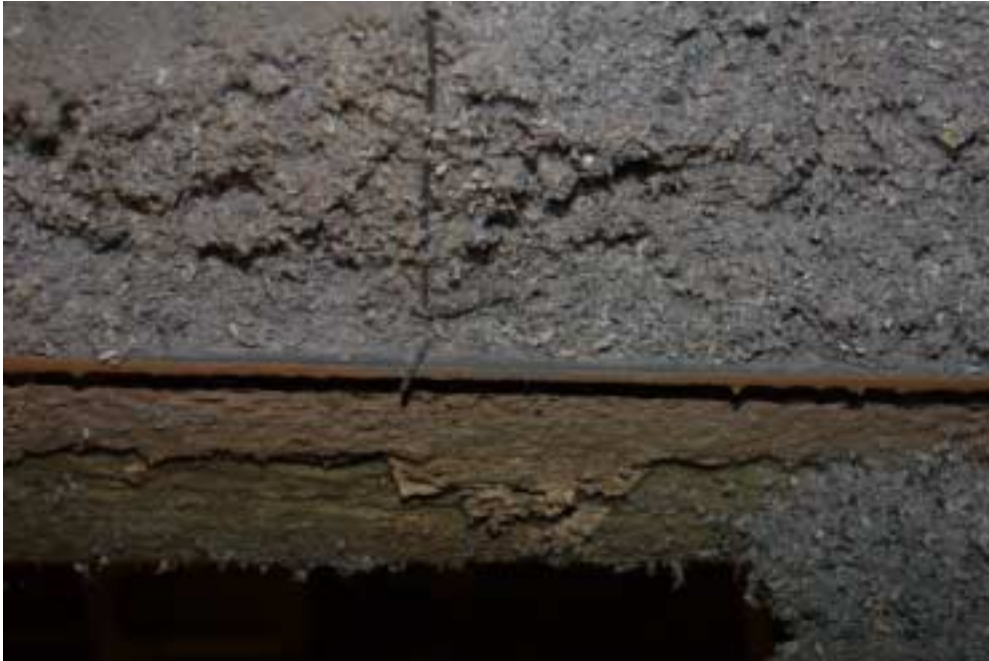
Kuva 6. Kannatuslista, joka on kiinnitetty sisäkaton villalevyihin muurauslaastia muistuttavalla kellertävällä sidosaineella. Kannatuslista riippuu kattoristikoiden päällä olevasta lankusta rautalangalla. Suurin osa kannatuslistoista pysyi kattovauriossa ylhäällä.
