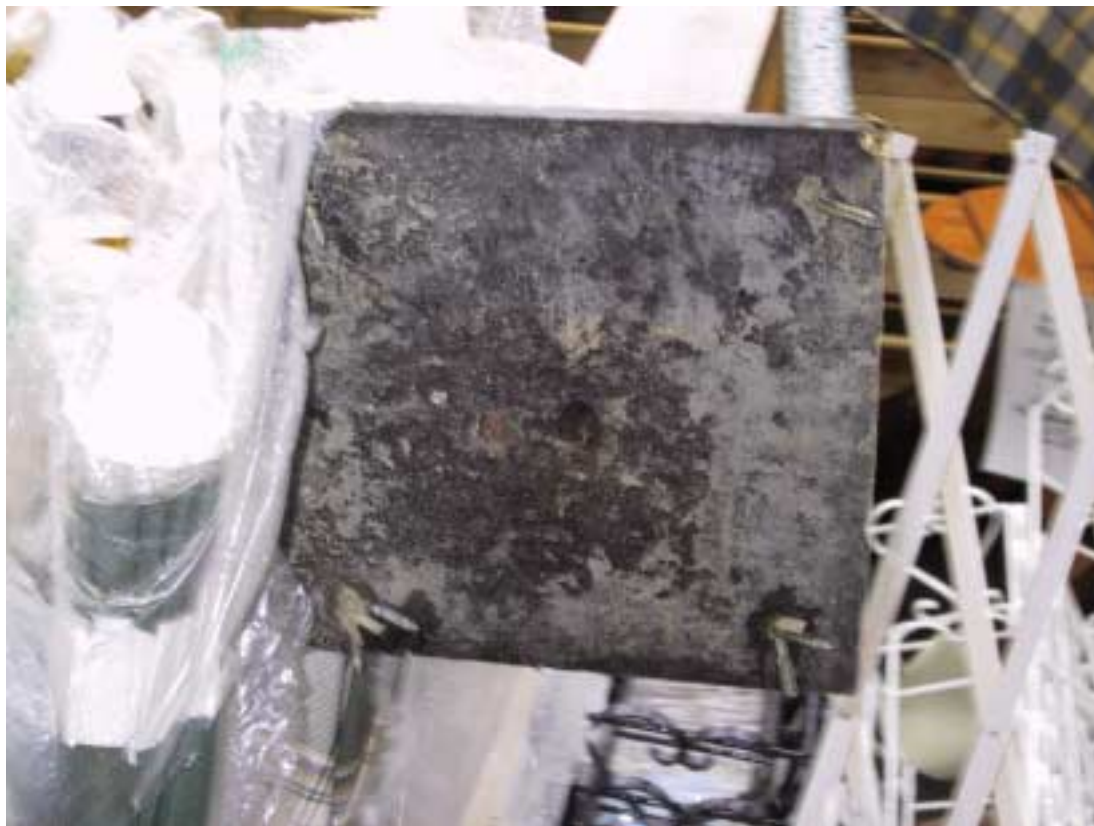
Kuva 6. Pilarien ankkurointi, joka oli tehty pienehköjen vanerilevyjen ja ruuvien avulla pihan asfalttipäällysteeseen. Vanerilevyn koko oli noin 250x250 mm.
