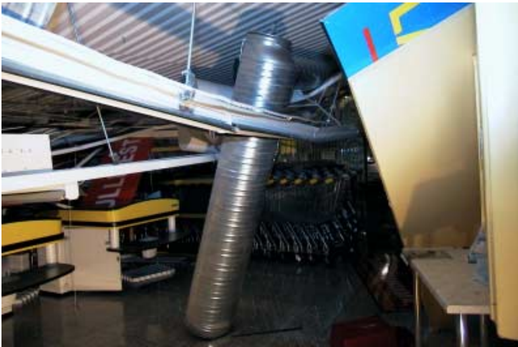
Kuva 2. Supermarketin sisäkaton putoaminen Pudasjärvellä 27.12.2000. Katon mukana putosi paljon mm. ilmanvaihtoputkia, valaisimia, sähköjohtohyllyjä ja somistelevyjä. Kuvassa näkyy, kuinka tavaraa tuli aina kassojen liukuhihnoille asti.
