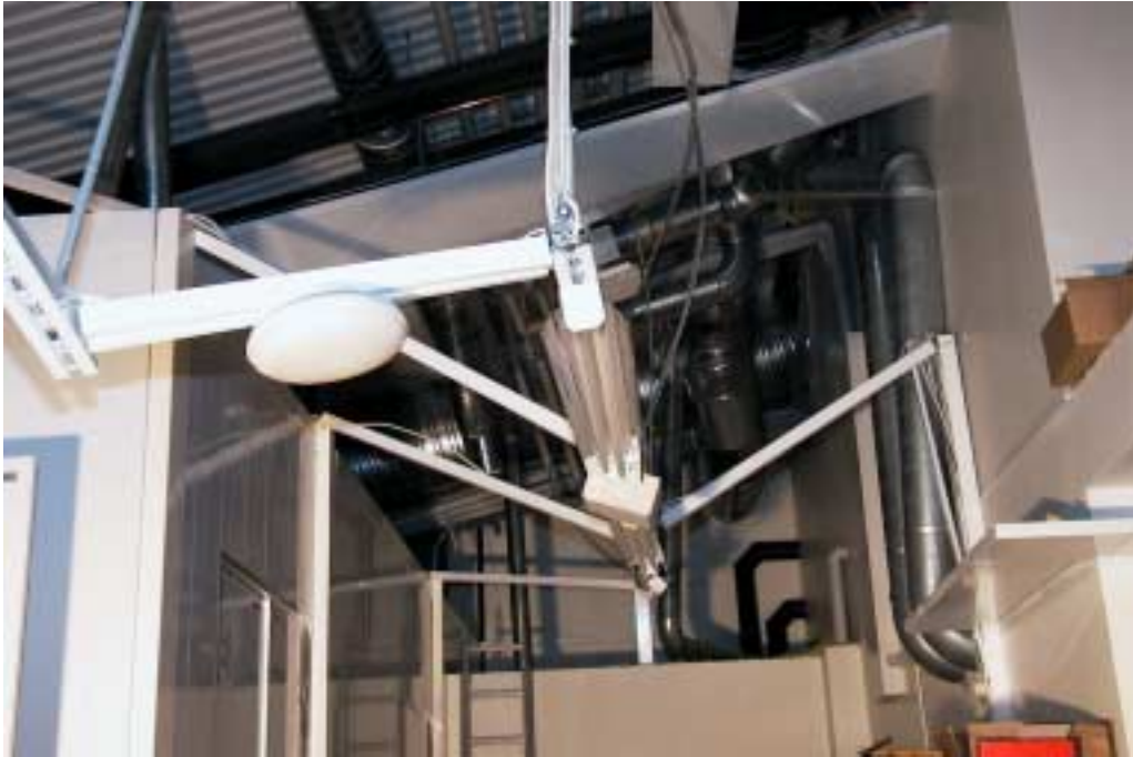
Kuva 3. Supermarketin sisäkaton putoaminen Pudasjärvellä 27.12.2000. Myymälän takaosan varaston katto. Oikealla on konehuone, josta vasemmalle myymälän suuntaan lähtee suuri määrä ilmanvaihtokanavia sekä vesi-, lämpö- ja kylmälaiteputkia. Kattovaurio on todennäköisesti alkanut juuri täältä alueelta.
