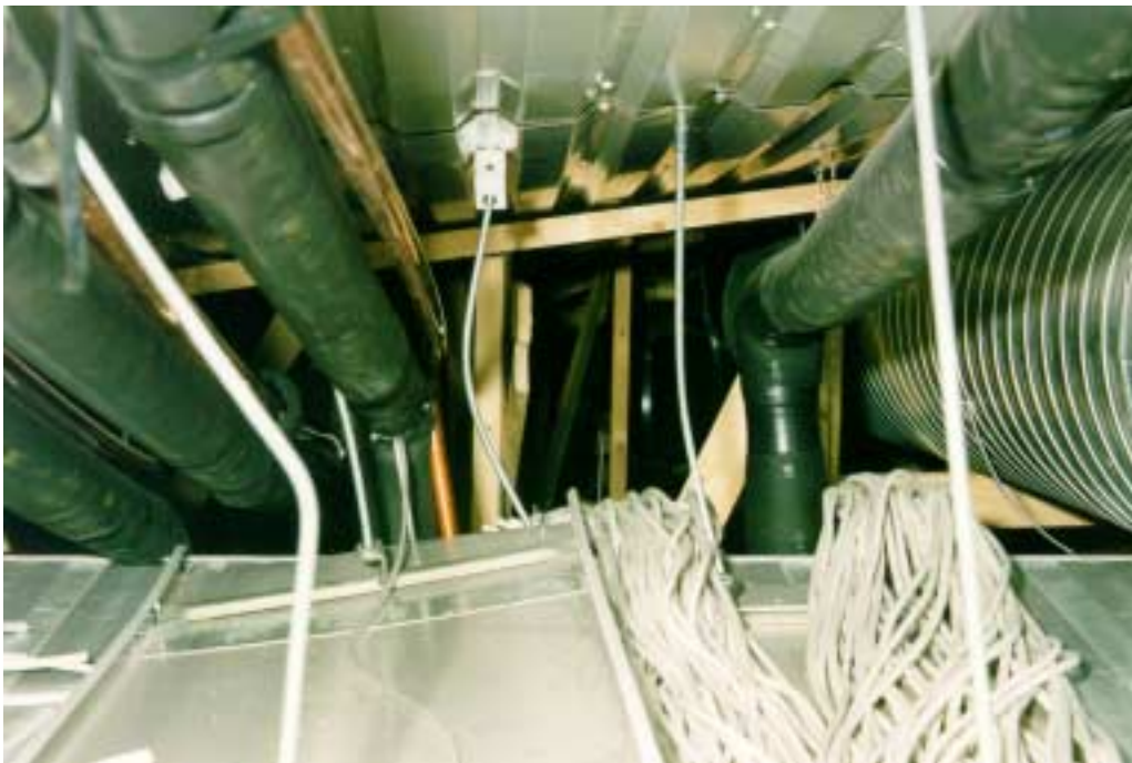
Kuva 4. Supermarketin sisäkaton putoaminen Pudasjärvellä 27.12.2000. Kuvassa ripustuskuormia aiheuttaneita paksuja mustalla eristeellä peitetyjä kylmälaiteputkia sekä ilmanvaihtokanava oikealla. Lisäksi sähköpääkeskuksesta lähti paljon sähköjohtohyllyjen päälle asennettuja sähköjohtoja. Kaikki oli ripustettu kierretangoilla myymälän sisäkaton profiilipellin alla olevaan harvalaudoitukseen.
