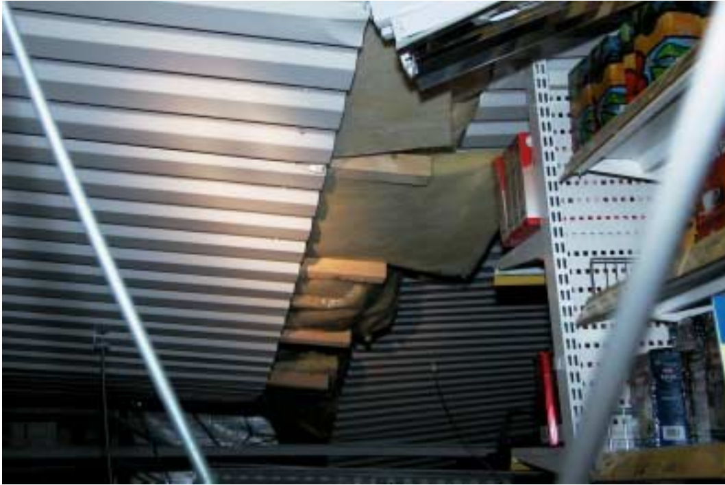
Kuva 5. Supermarketin sisäkaton putoaminen Pudasjärvellä 27.12.2000. Sisäkaton rimojen naulauksessa havaittiin joitakin pienehköjä virheitä kuten ohimenneitä ja puuttuvia nauloja. Kuvan kohdassa lähes kaikkien rimojen jatkokset oli tehty saman kattoristikon kohdalle, jolloin kattoon syntyi heikompi epäjatkuvuuskohta.
