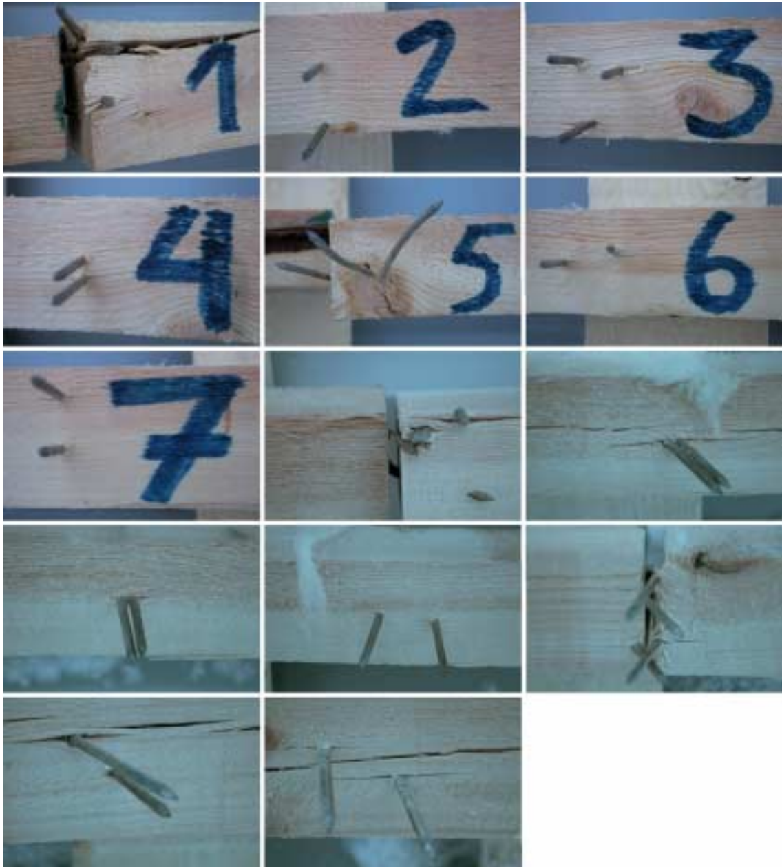
Kuva 7. Supermarketin sisäkaton putoaminen Pudasjärvellä 27.12.2000. Kuvakollaasi naulauksista, joilla sisäkaton rimat oli kiinnitetty kattoristikoihin. Kuvat on otettu tutkintalautakunnan satunnaisesta katon kohdasta otetusta näytepalasta. Kuvasta ei kuitenkaan käy ilmi, mitkä nauloista ovat osuneet kattoristikkoon.
