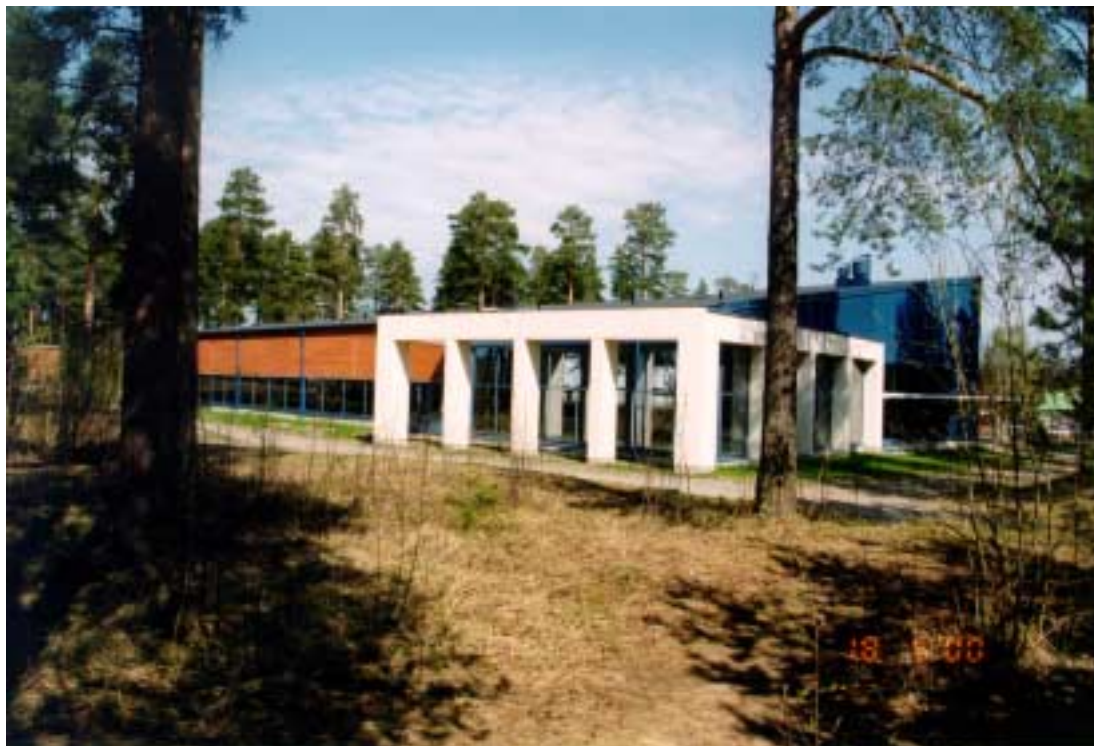
Kuva 3. Iisalmen uimahalli vuosien 1995-1996 saneerauksen ja laajennuksen jälkeen. Kaari- ja tasakaton yhdistelmä on muutettu pulpettikatoksi. Kuva on otettu samasta suunnasta kuin kuva 2.
