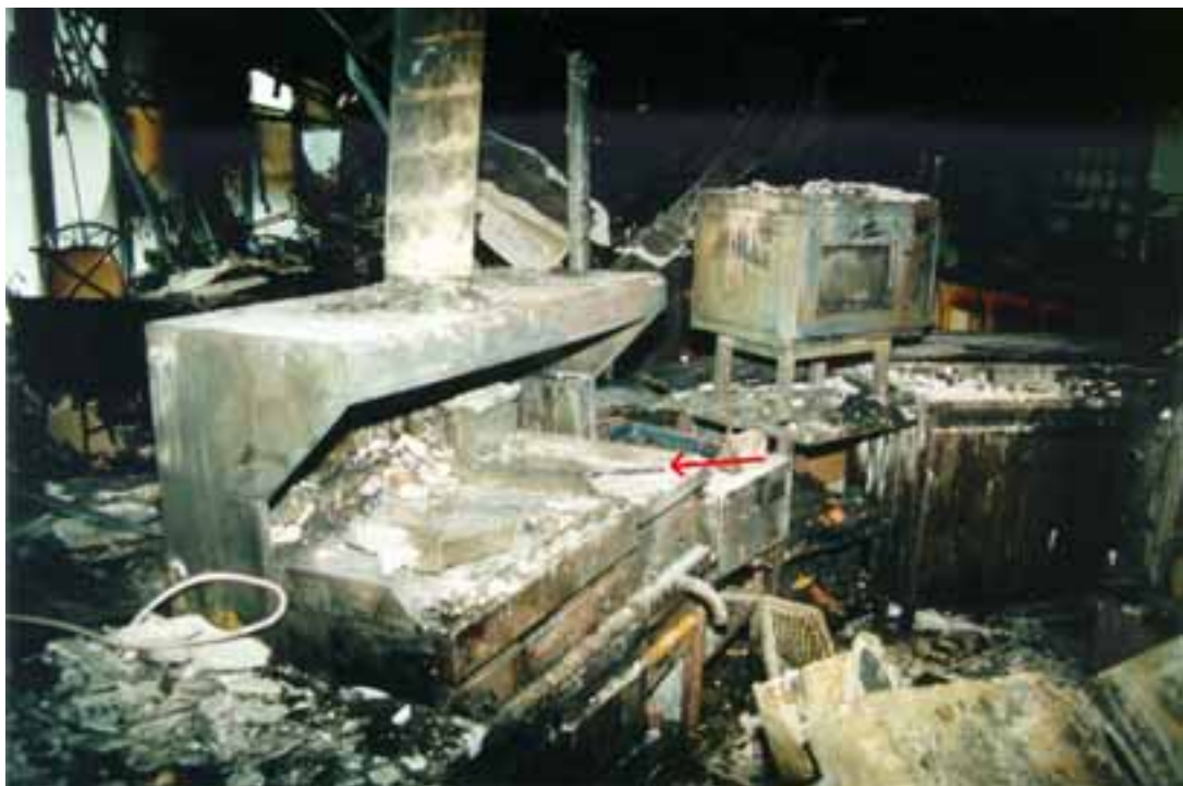
Kuva 10. Etualalla paistotaso, nuolella merkitty rasvakeitin ja niiden yläpuolella, noin 40 cm korkeammalla, huuva, jonka päällä oli muun muassa lautasliinoja ja hampurilaispakkauksia. Huuvan yläpuolella paloeristämätön kohdepoistokanava.
