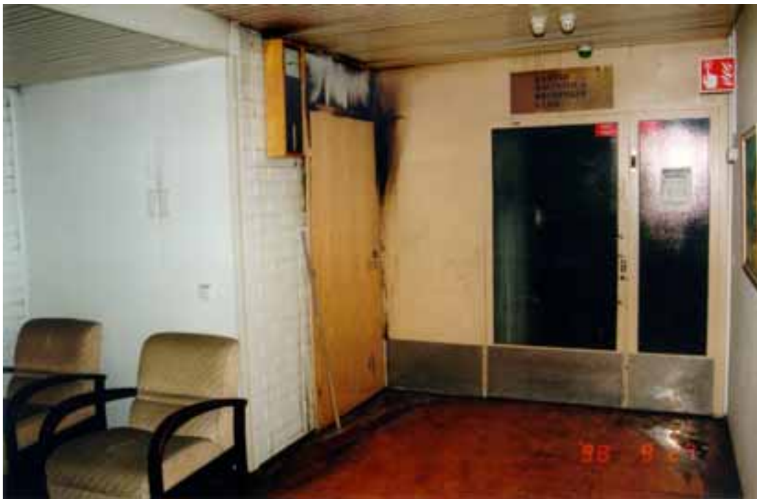
Kuva 26. Paloalueen viereinen aula, jonka automaattiset palo-ovet olivat auki. Toinen katossa olevista savuilmaisimista liittyy suljinlaitteistoon, jonka ohjausyksikkö ei kuitenkaan toiminut.
