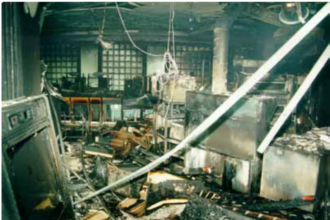
Kuva 12. Keittiötila syttymisalueella. Alakattorakenteita on romahtanut. Taustalla aula-ravintolan ja allasosaston välinen osastoiva lasitiiliseinä.
