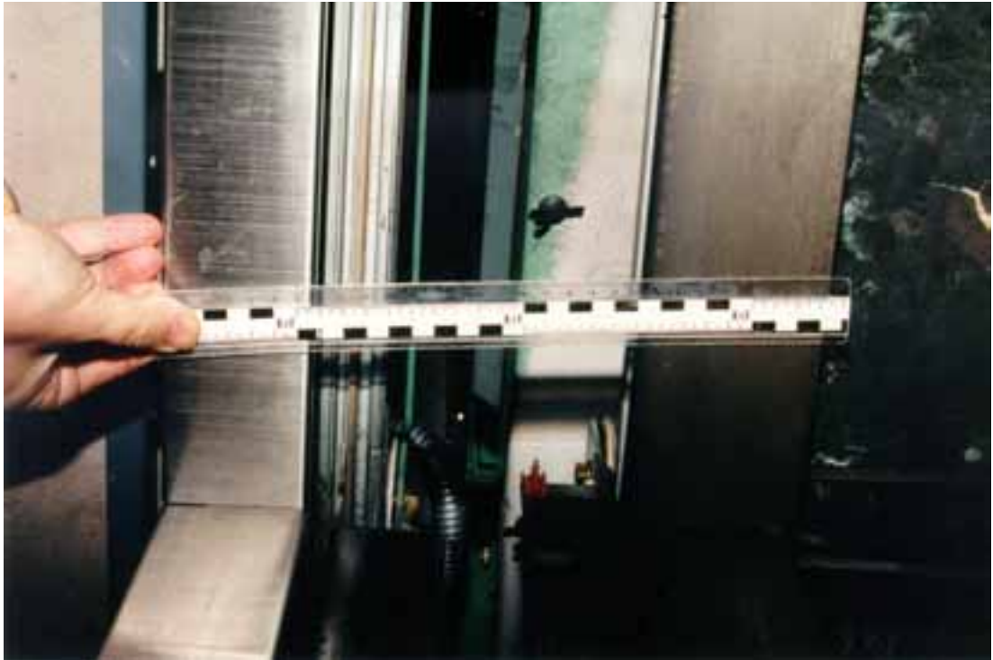
Kuva 16. Hissin oven ollessa auki hissikuilun ja hissikorin välissä on yli 5 cm aukko. Kuvassa oviaukon yläreuna siten, että vasemmalla on harmaa hissikorin katto.
