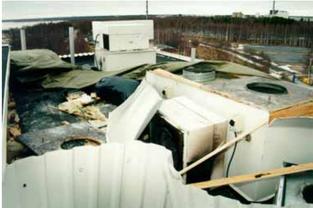
Kuva 13. Palo levisi keittiön poistoilmahormin kautta viisikerroksisen rakennuksen vesikatton puurakenteisiin. Kattorakenteita on jouduttu raivaamaan sammutuksen yhteydessä.
