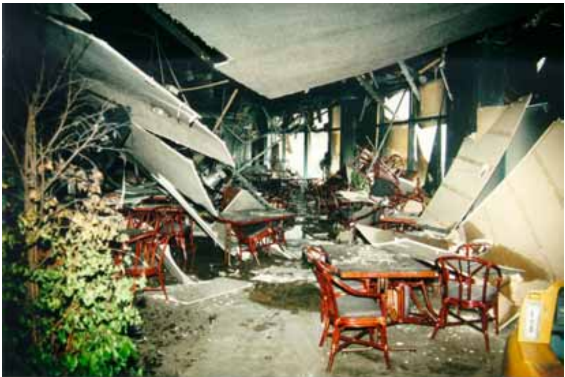
Kuva 6. Aulabaari palon jälkeen ennen raivausta. Paloalue on aulan perällä.
