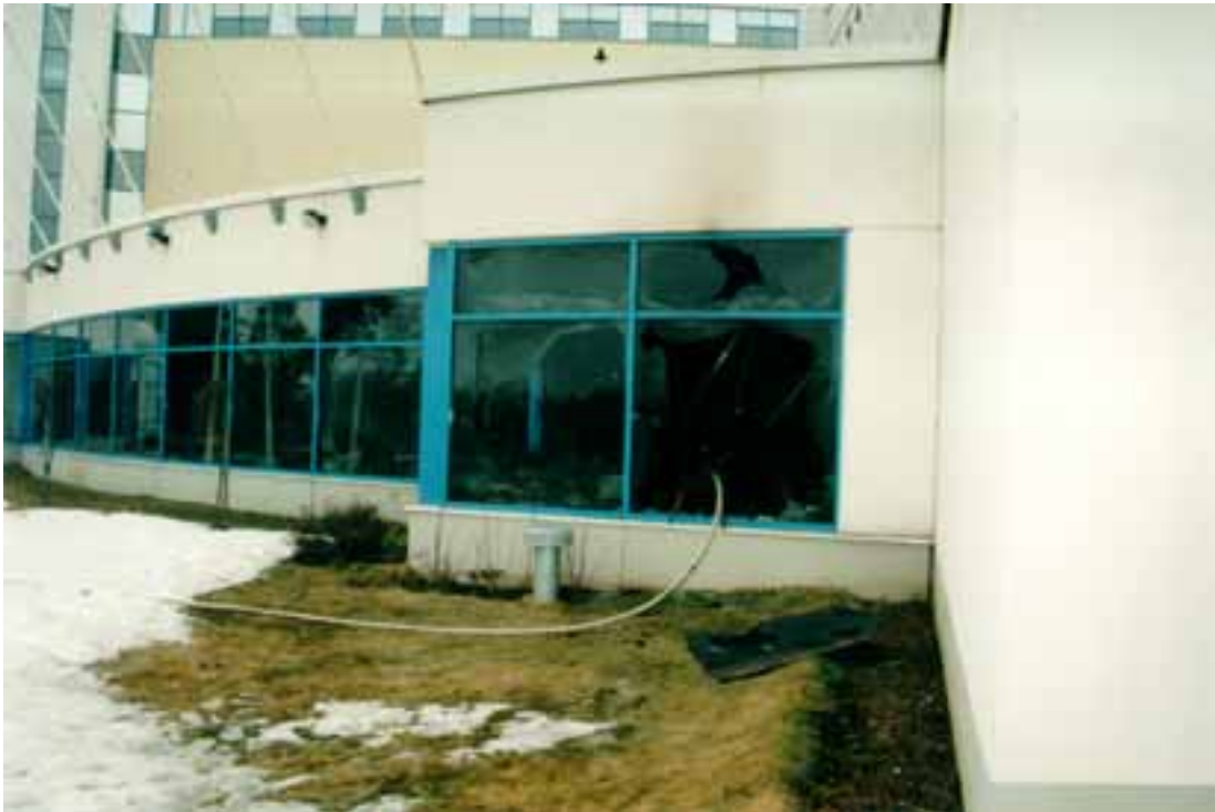
Kuva 7. Aularavintolan ulkopuoli palokohdan läheltä.
