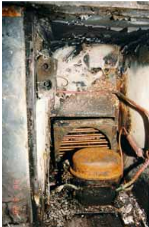
Kuva 25. Kylmäaltaan kompressori ja putkistoa.
