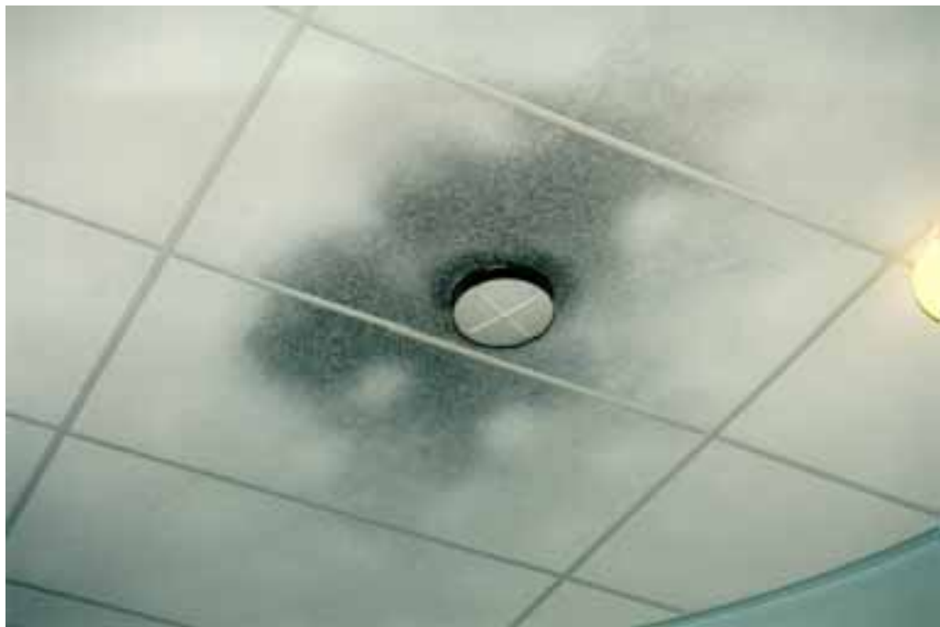
Kuva 14. Savua levisi kylpylähotellin eri osiin myös ilmanvaihtojärjestelmän kautta.
