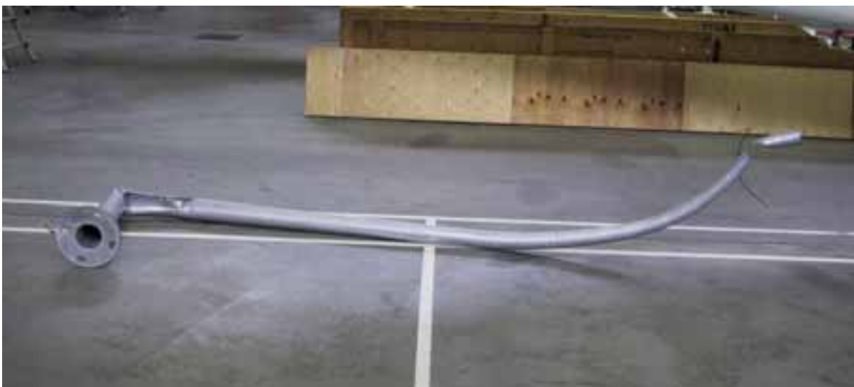
Kuva 7. Valaisinpylväs, johon helikopterin roottorinlavat osuivat
