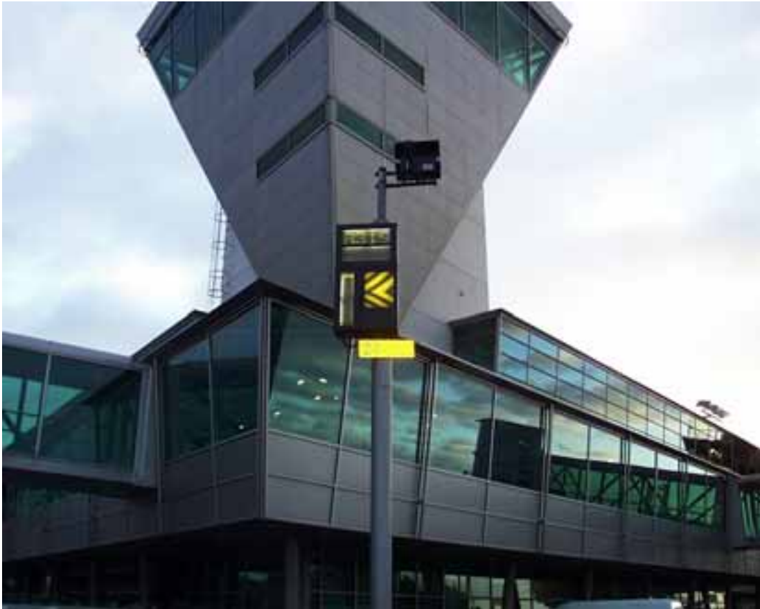
Kuva 2. APIS-näyttö kuvattuna törmäystilanteen jälkeen. Sivusuuntanäyttö opastaa vasemmalle, koska kuva on otettu keskilinjalta eikä vasemman ohjaajan paikalta. Vasemmalla olevassa etäisyysnäytössä on yhä kaksi "palkkia" jäljellä osoittaen noin 1,2 m:n kuljettavaa matkaa.
