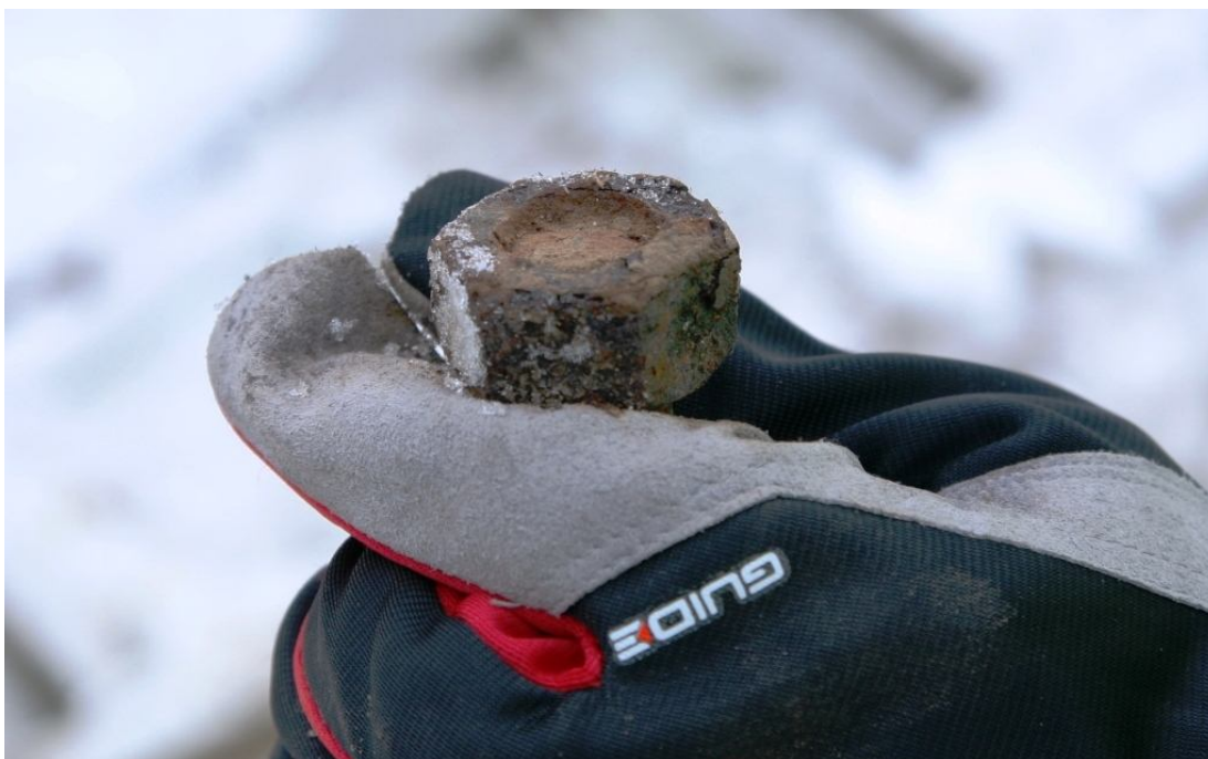
Kuva 6. Riittämätön peruspultin tunkeuma mutteriin nähden.
