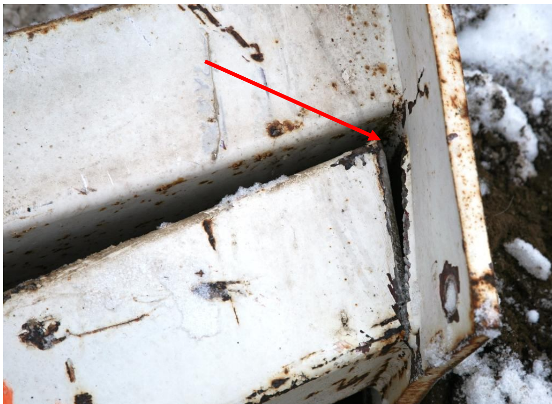
Kuva 11. Harjaliitoskappale, jonka ympärihitsaus oli mahdotonta tilanpuutteen takia. (kuva: poliisi)
