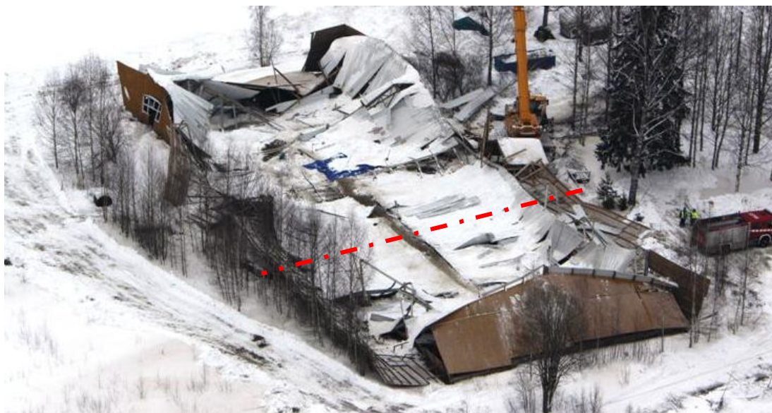
Kuva 2. Sortunut maneesirakennus. Kuva on otettu lännen suunnasta. Teräskehät kääntyivät kohti pistekatkoviivalla merkittyä kohtaa. (kuva: Puolustusvoimat)
