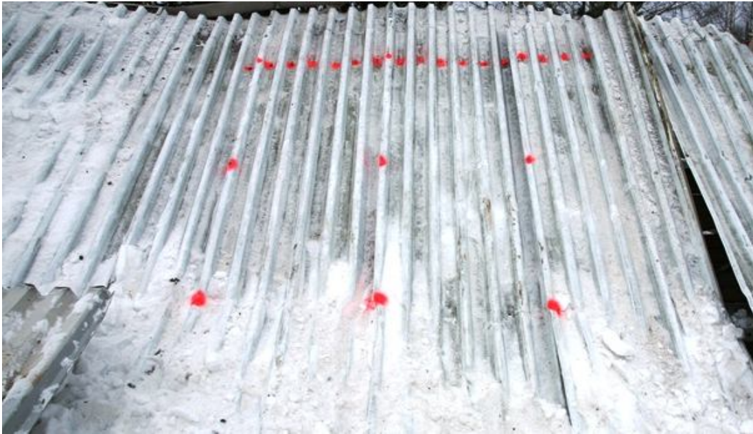
Kuva 7. Poimulevyn ruuvausrasteri. Kuva harjalta räystäälle päin.
