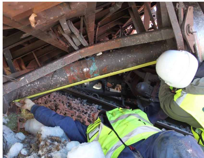
Onnettomuustutkintakeskuksen paikkatutkijat tutkivat kiskoilta pudonnutta vaunua ja sen vaurioita.
