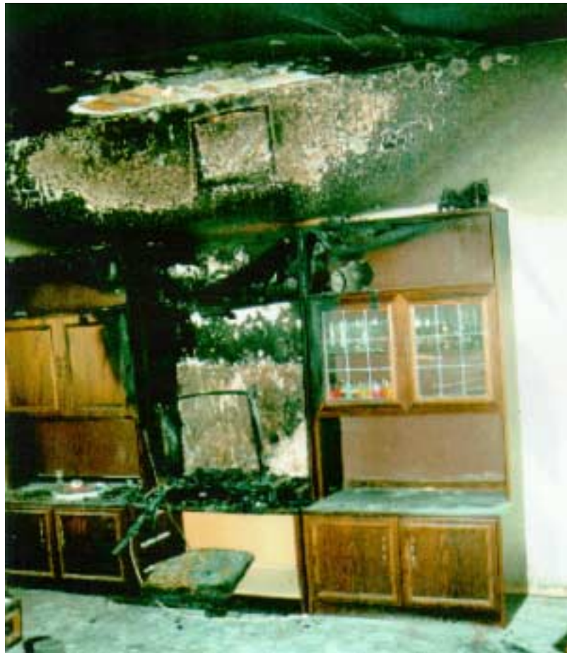
Kuva 2. Kirjahylly palon jälkeen. V-muotoiset palokuviot lähtevät ylöspäin hyllyn keskeltä, missä TV oli.
