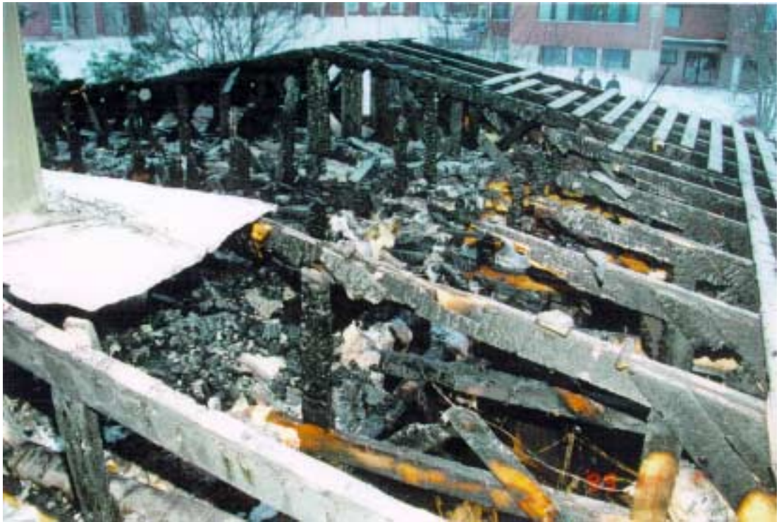
Kuva 3. Kuusi kattoristikkoa paloi poikki palaneen asunnon kohdalla.
