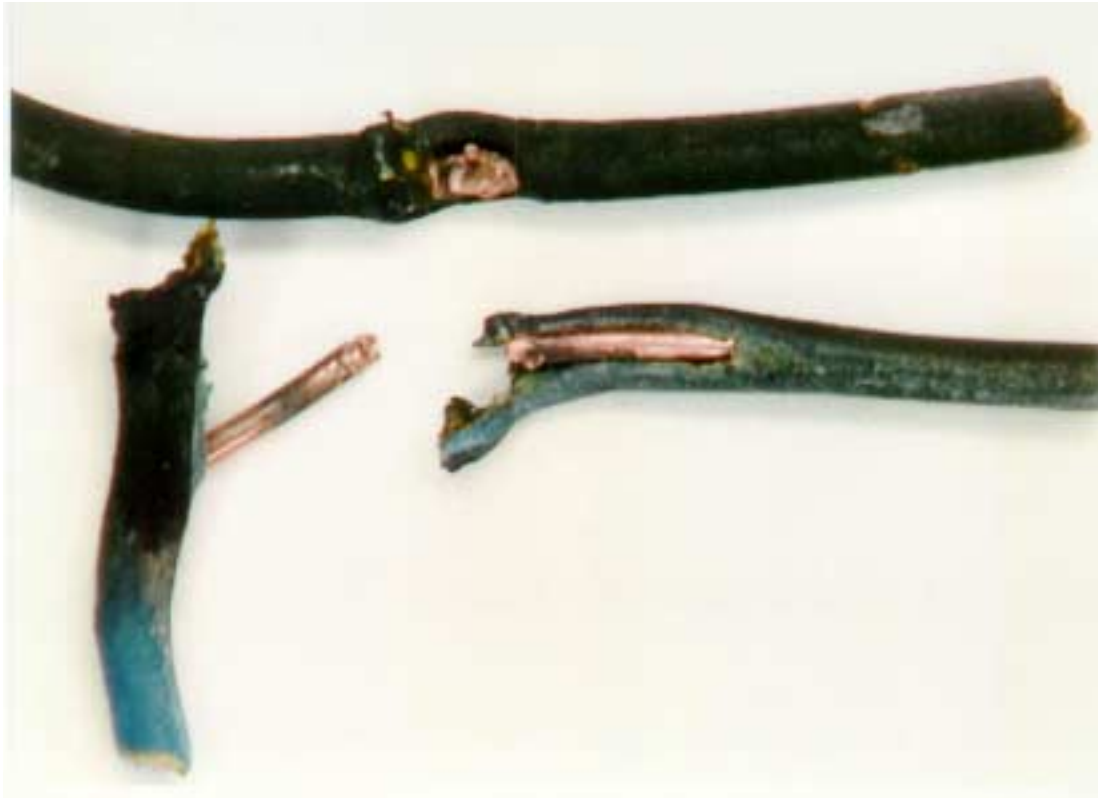
Kuva 4. Oikosulun merkit sähköpääkeskuksen johdoissa. Ylempänä liedelle menevä johto, jossa oikosulun aiheuttama sulamisjälki. Alempana poikki mennyt, valaistukseen kuuluva 0-johto.
