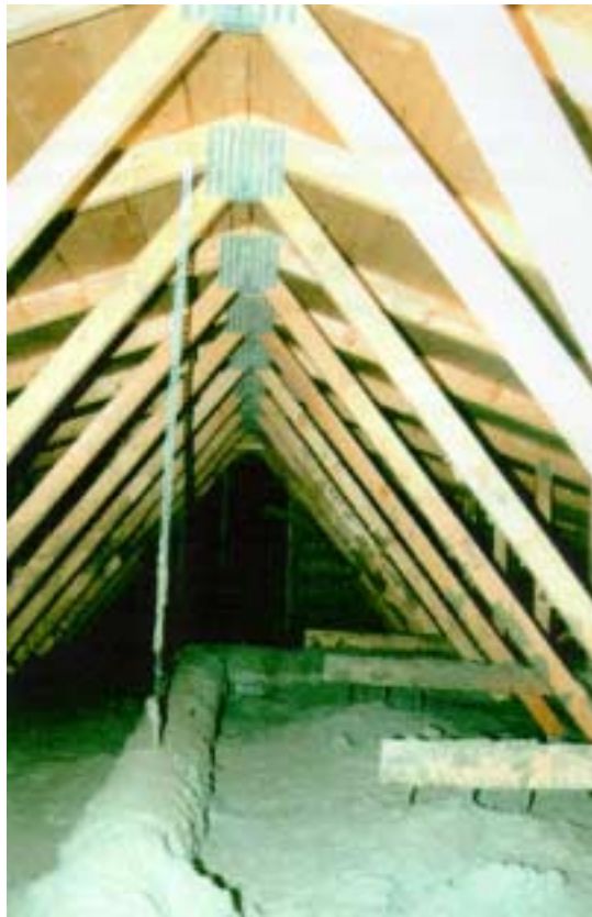
Kuva 3. C-talon avoin yläpohjan ontelo.
