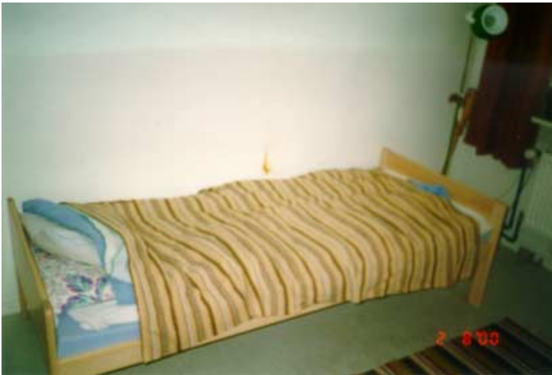
Kuva 1. Vuode, jonka yläpuolella vaaratilanteen aiheuttanut valaisin oli kiinnitetty seinään suunnilleen seinässä olevan, kytevän pyyheliinan synnyttämän ruskean läikän yläpuolelle.
