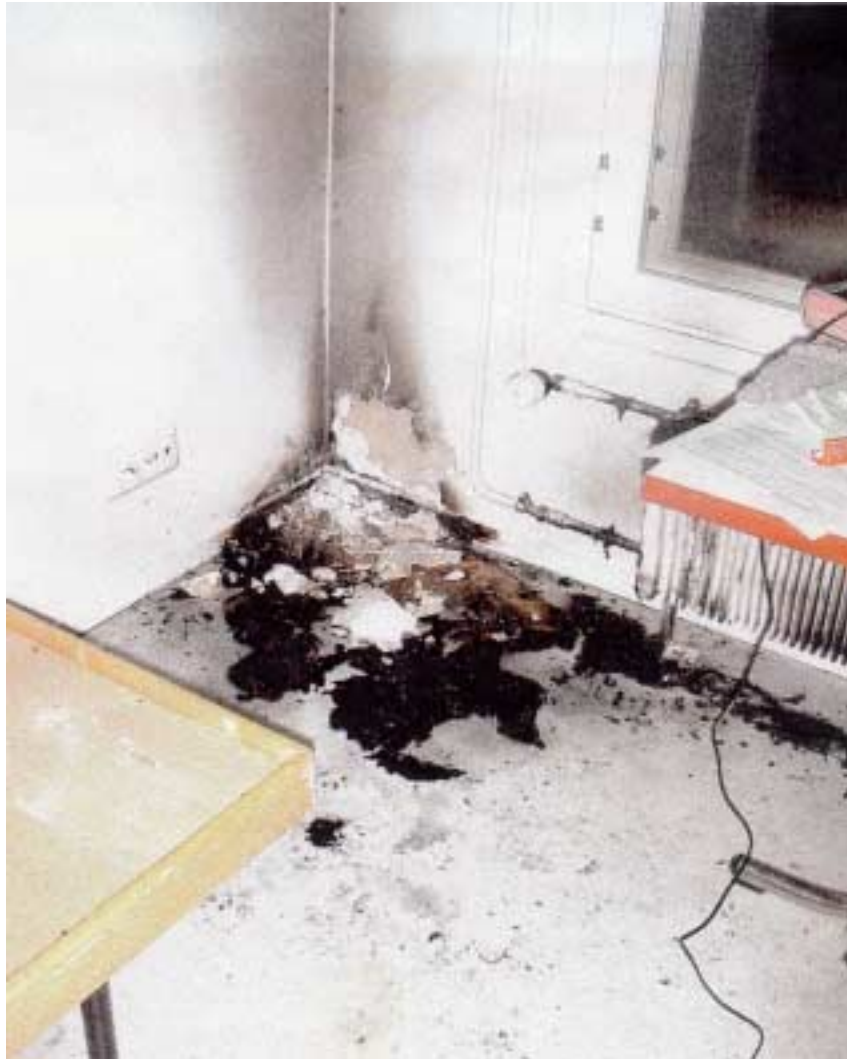
Kuva 1. Asunnon pahiten palanut kohta, makuuhuoneen ikkunasta vasempaan oleva nurkka. Liekit näkyivät viimeksi lattian muovimatossa.
