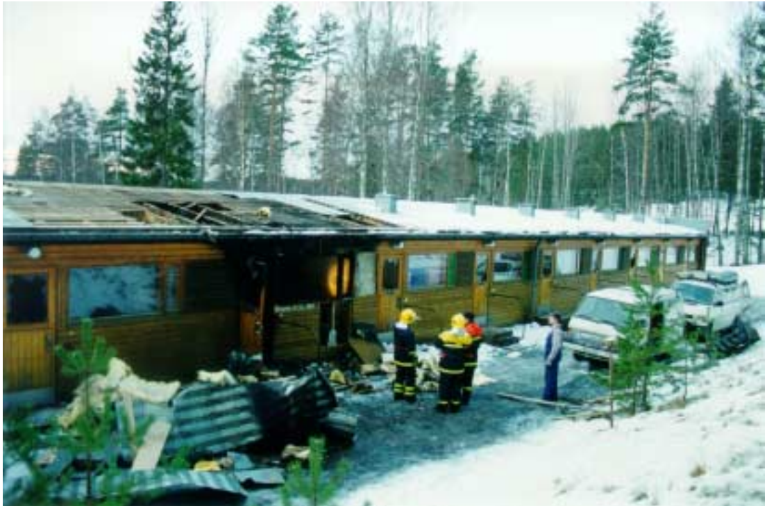
Kuva 1. Rivitalon Hokkarintie 7 julkisivu palaneen asunnon 8 kohdalta. Katto on jouduttu repimään osittain auki.
