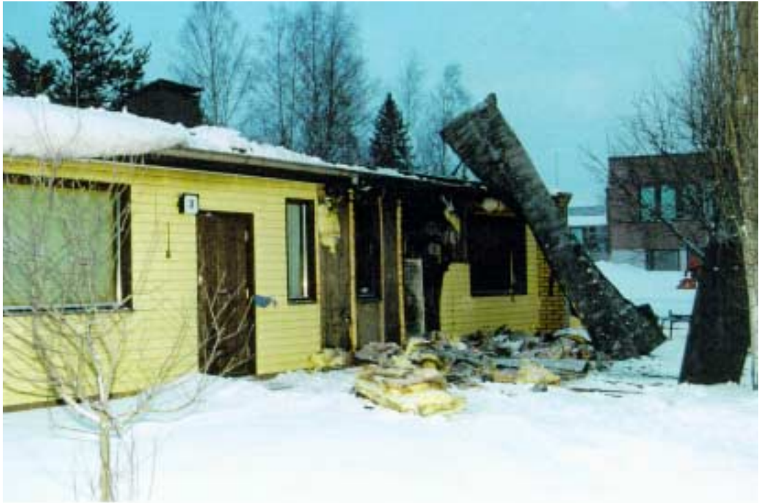
Kuva 1. Särkängtie 3 E:n idänpuoleista sivua palon jälkeen. Asunto 3 E 4 on tuhoutunut pahoin. Taloa vasten nojaa irrotettu kattopelti.
