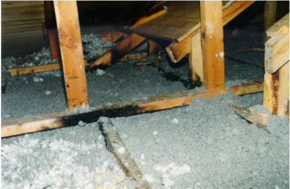
Kuva 1. Nokeentumia ja hiiltymiä kattoristikoissa.
