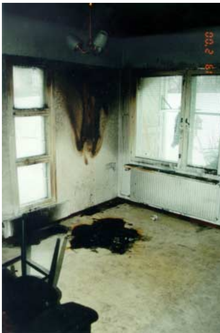
Kuva 1. Televisio paloi lattialla olevan mustan läikän kohdalla. Seinällä ikkunoiden välissä näkyy palaneen ryijyn kohta. Katto on pahoin mustunut.
