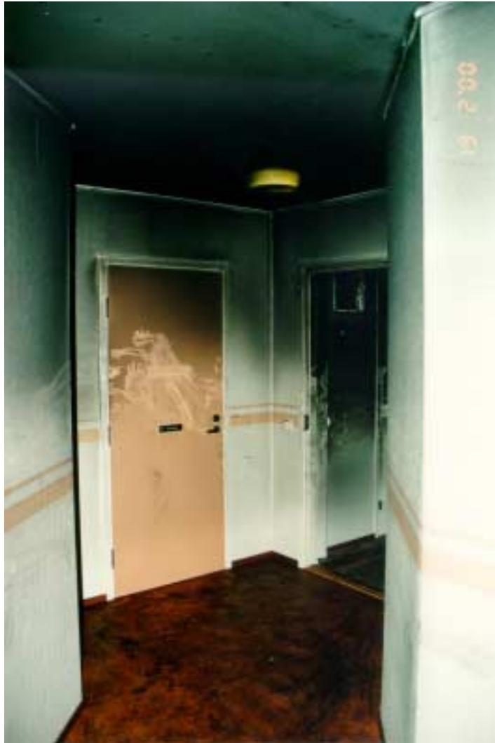
Kuva 2. Savu ja nokivahinkoja eteisaulassa.
