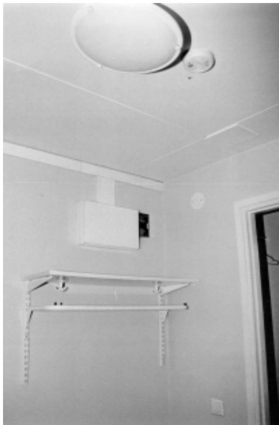
Kuva 1. Kehrääjänkatu 6:ssa olevan asunnon eteisen naulakkosyvennyks. Kuva otettu naapuriasunnosta. Hattuhyllyn yläpuolella seinässä huoneiston sähköpääkeskus. Pääkeskuksen oikealla puolella ovikello.
