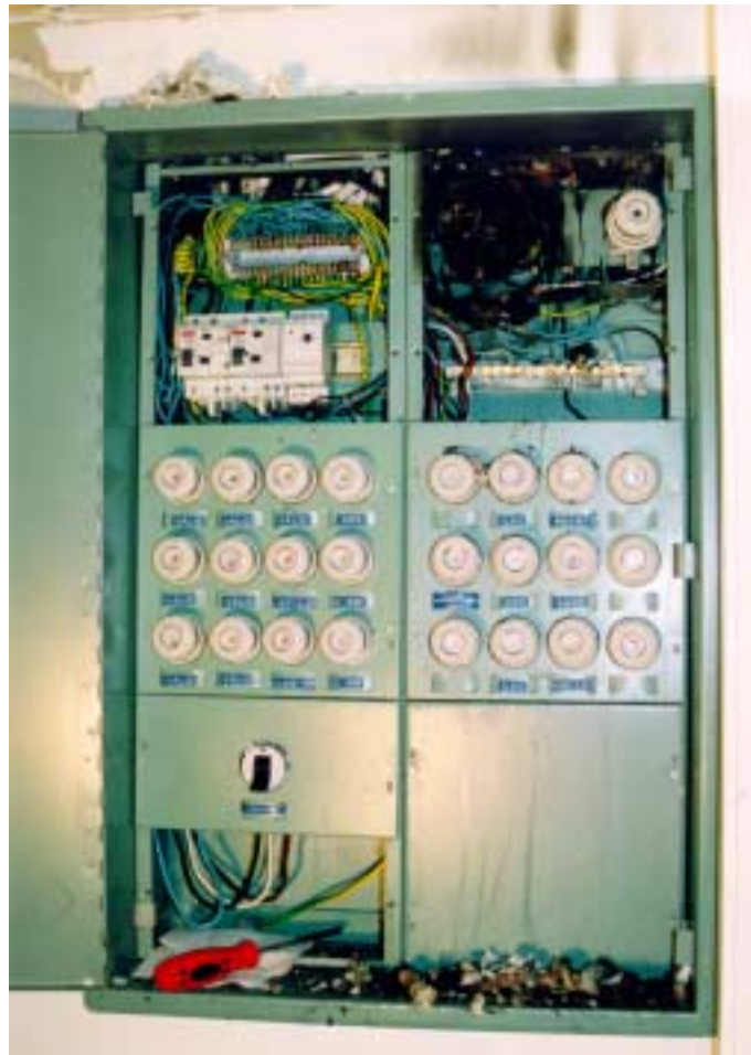
Kuva 2. Sähköpääkeskus palon jälkeen. Palanut soittokellomuuntaja oikealla ylhäällä yksinäisen sulakkeen vasemmalla puolella.
