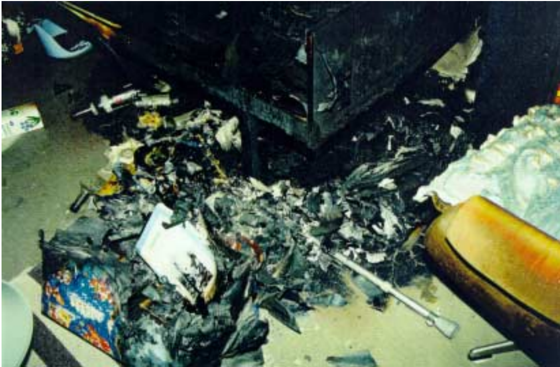
Kuva 3. Kyynärsauva oli lattialla vaakasuorassa asennossa, osittain laatikoiden palojäänteiden sisällä.
