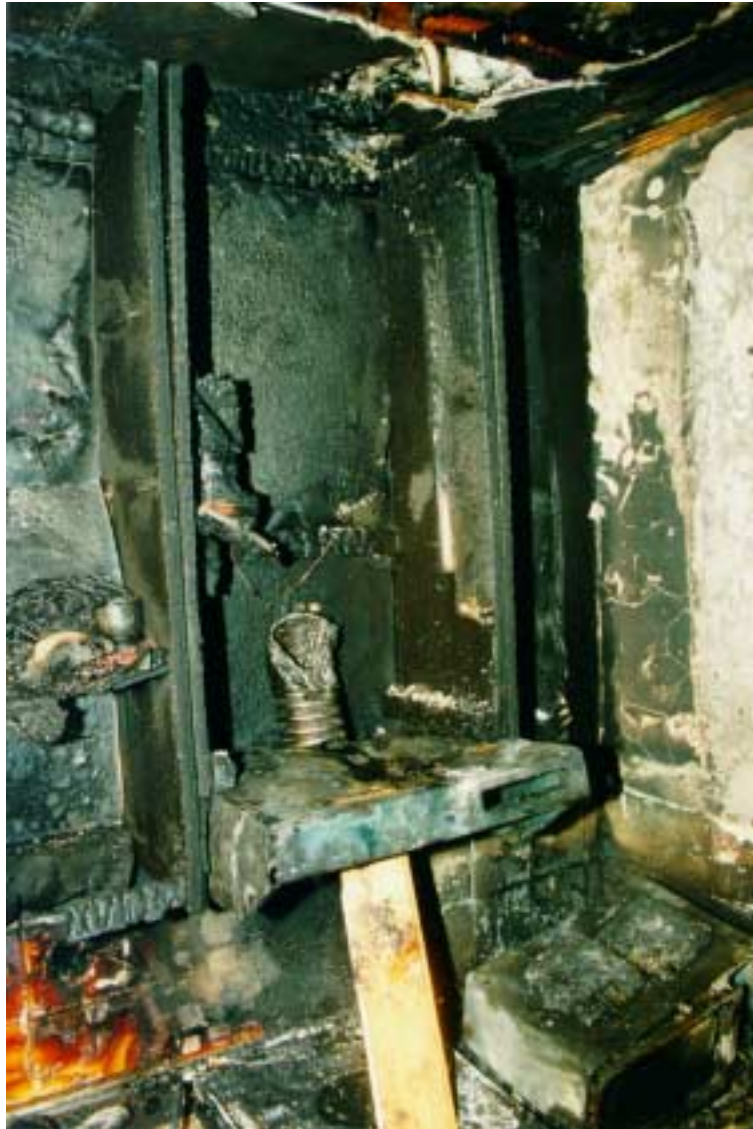
Kuva 2. Sisäkuva asunnon 8 pahoin tuhoutuneesta keittiöstä. Liesituuletin, josta palo alkoi, on jouduttu tukemaan liettä vasten laudanpätkällä.
