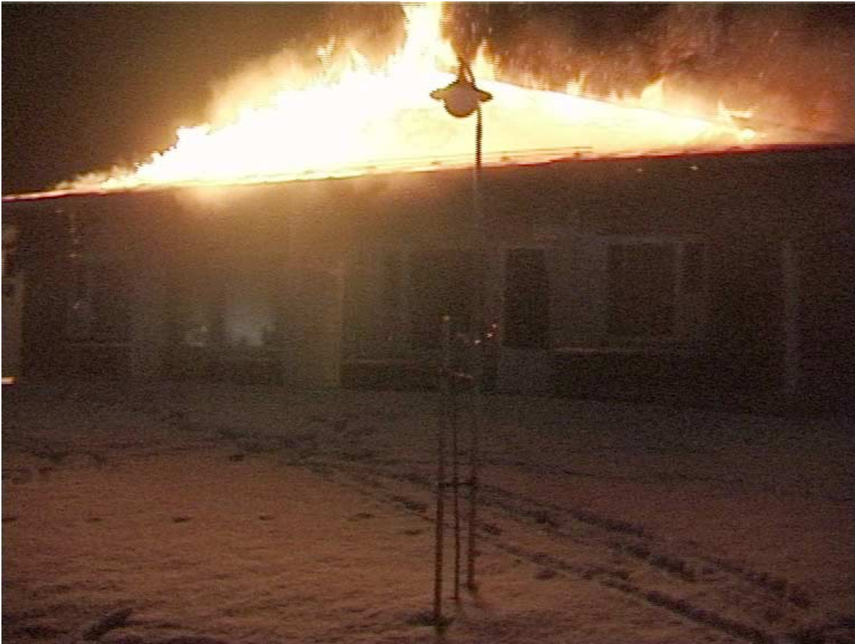
Kuva 6. Kuva aluepalopäällikön varamiehen kuvaamalta videonauhalla. Länsisiiven pääty palaa. Videon kellonaika 00.24.
