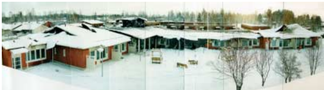
Kuva 3. Palvelutalo Viljami pohjoispuolelta. Vasemmalla pohjoissiipi. Keskellä puutarhakeinujen välissä asunto 2, josta palo sai alkunsa.
