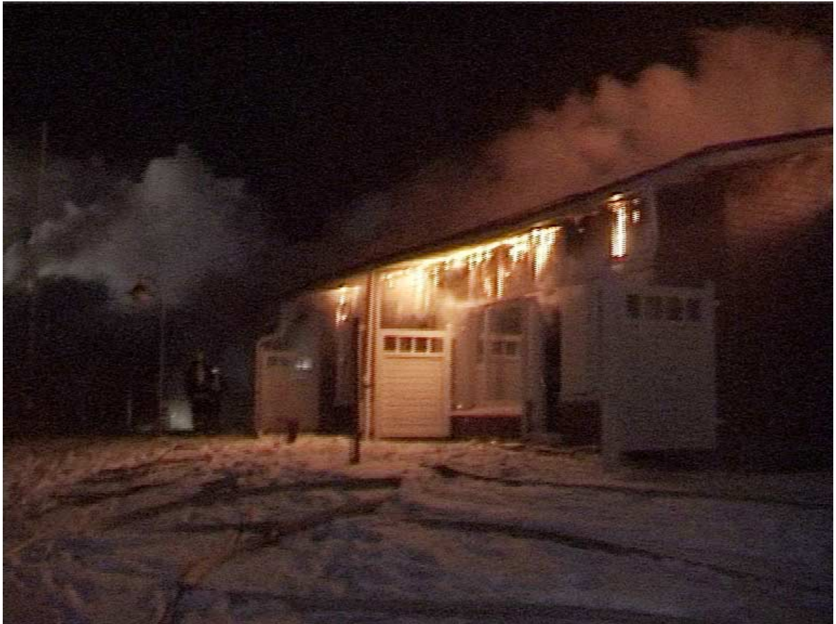
Kuva 7. Kuva aluepalopäällikön varamiehen kuvaamalta videonauhalla. Puurakenteinen seinä asuntojen 5 ja 6 ikkunoiden yläpuolella on palanut lähes puhki. Videon kellonaika 00.29.
