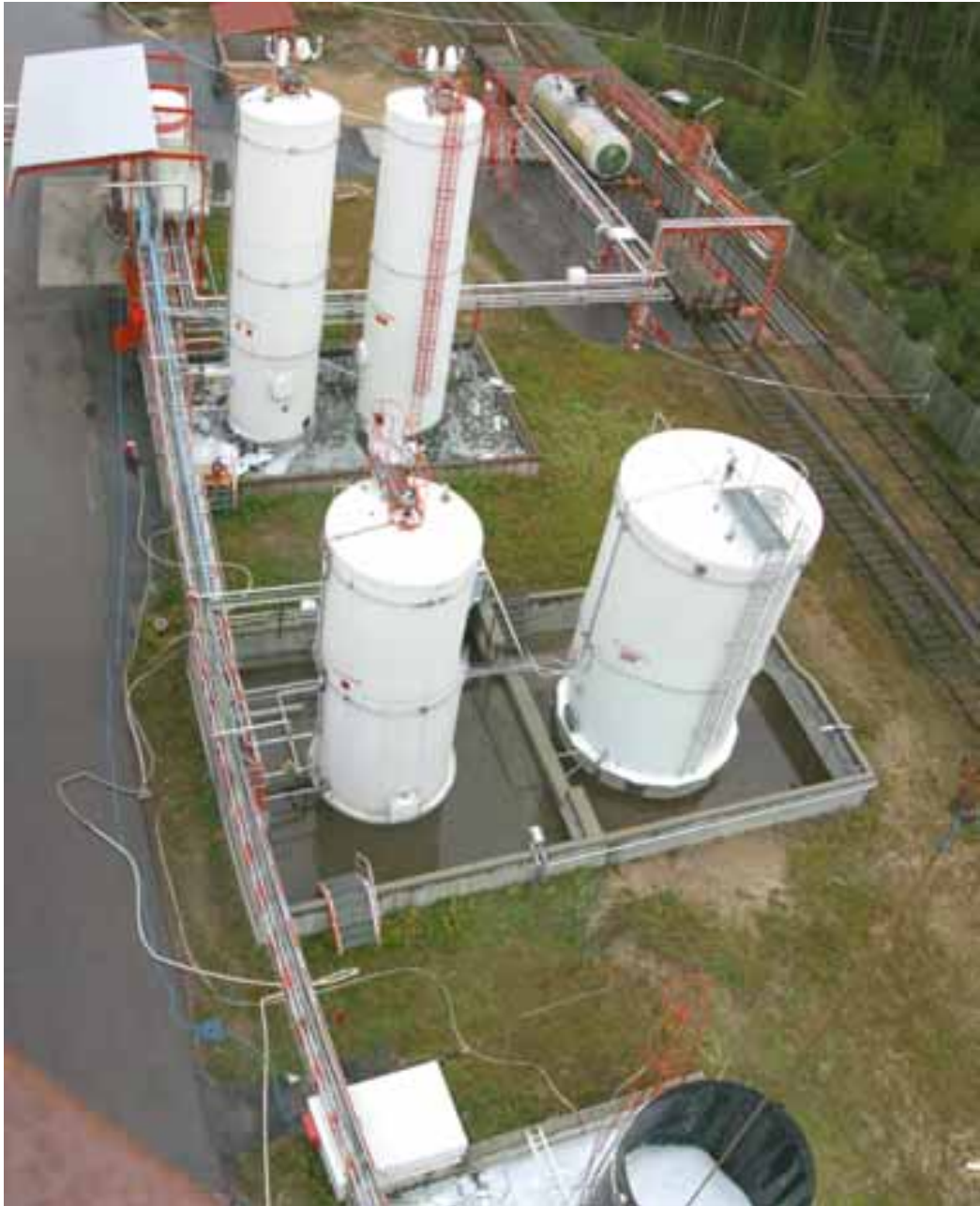
Kuva 7. Kuva monomeerisäiliöalueesta. Räjähäntänyt akryylinitriilisäiliö on kuvan alareunassa. Etualalla on kaksi styreenisäiliötä ja taaempana kaksi butadieenisäiliötä. Autonpurkupaikka on butadieenisäiliöiden vasemmalla puolella oleva katettu tila ja junanpurkupaikka kuvan yläreunassa oikealla. Säiliövaunun oikealla puolella, aidan takana, on räjähdyksessä säiliöstä revennyt kansi.
