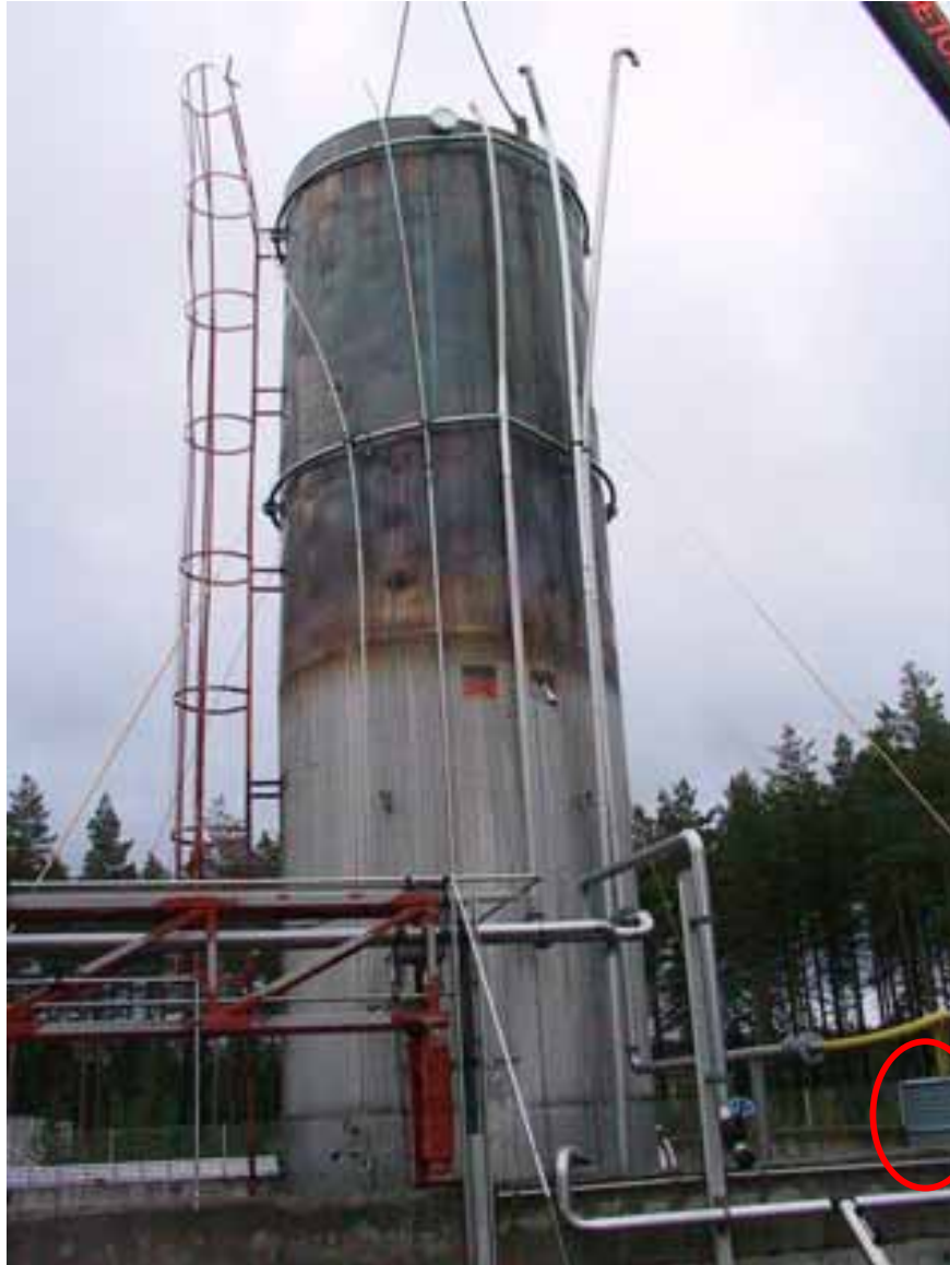
Kuva 4. Akryylinitriilisäiliö sammutustöiden jälkeen. Kuvan oikeassa alareunassa on juuri ennen onnettomuutta uusittu metallitynnyriin tehty aktiivihilisuodatin.
